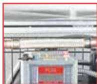
LIQUID LINE VIBRATION ABSORBER (SEMI-HERMETIC ONLY)
