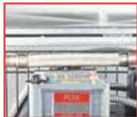
LIQUID LINE VIBRATION ABSORBER
